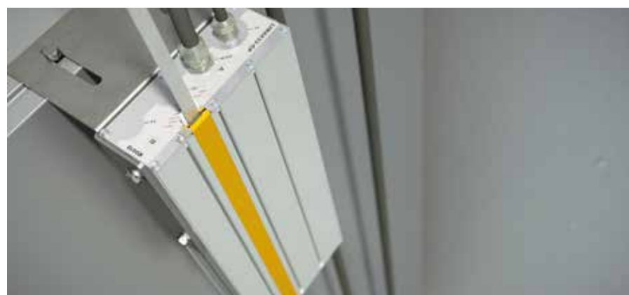
LIMAX im Schacht
